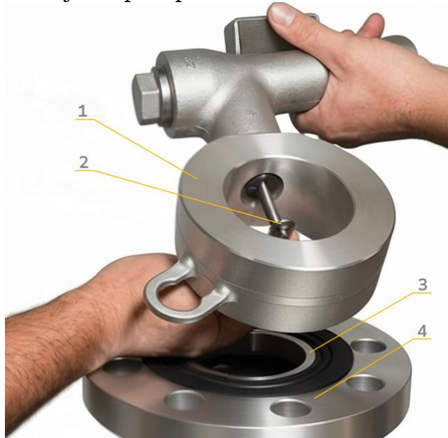
Рисунок 9 – Монтаж кожуха
